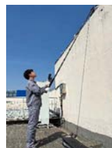
inspection de la toiture
