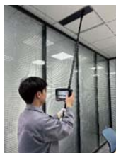
inspection des conduits de plafond
